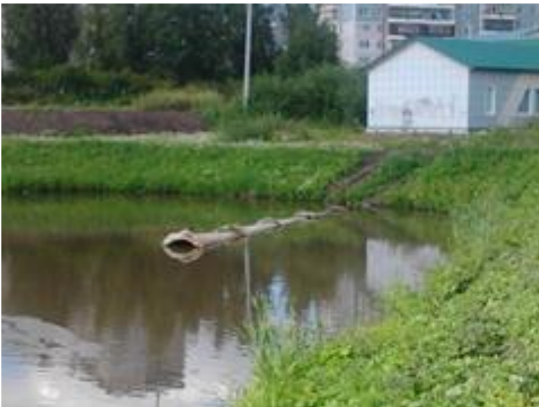
Фото . Выровненный и укрепленный склон после расчистки.
